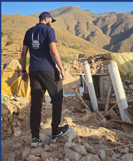
Hassaan Ghani Sheikh von Islamic Relief blickt auf die Trümmer der zerstörten Häuser im Dorf Tagadir in Chichaoua, Marokko.
